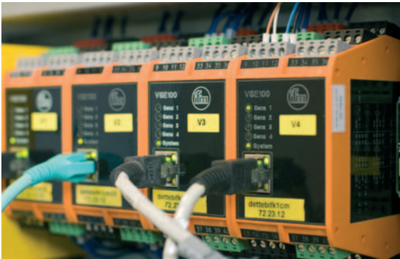
Die Auswerteeinheiten VSE100 werten die Sensorsignale aus und leiten den Status per Ethernet an die Steuerung
